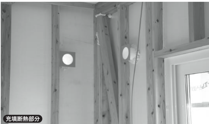
新工法の遮熱・外断熱施工
