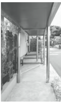
車庫から続く玄関エントランス
