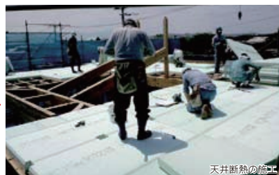
天井断熱の施工 ▲天井断熱の施工は、棟上げの時に完了する。断熱材の間の穴部分は、屋根構造の柱が立てられる。断熱材の厚さは、100mmが標準である。断熱材と断熱材の取り合い部分には、気密テープが貼られて断熱性能とともに最も重要な気密施工も同時に終わられる。100mm厚の断熱材は人が乗っても全く問題の無い強度である。
