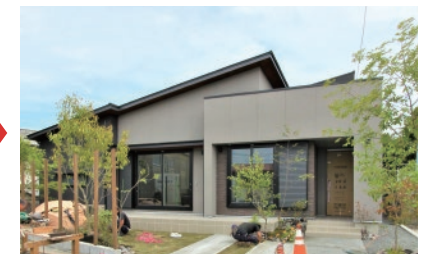
▲この施工現場は吹付け塗装施工の現場である。希望によりサイディング施工など、様々な外壁材を施工することも可能である。サイディングやモルタルの他にもガルバリウムなどの外壁材があり、地域にあった外壁材を選択する事が可能である。
