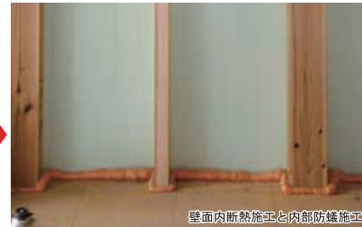
壁面内断熱施工と内部防蟻施工 ▲ハイブリッド・エコ・ハートQの場合は、内断熱と外断熱のダブル断熱施工が行われる。床構造材と柱・断熱材の隙間は、防蟻フォームによって断熱補強される。防蟻フォームはVOC（揮発性有機化合物）を発生させない優れた物性がある。
