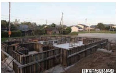
耐圧盤と鋼製型枠 ▲耐圧盤の完成後、耐圧盤から立ち上げている配筋に鋼製型枠を組み上げコンクリートを流し込む。鋼製型枠は従来の木製型枠と異なり、精度が高く基礎の天端が均一の高さに保たれる。天端が均一でない基礎と土台の施工も一定せず、アンカーボルトも正確に土台を固定できない。
