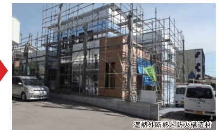
遮熱外断熱と防火構造材 ▲防火構造材の上に、遮熱面材を貼り付けた外断熱材が施工される。これで断熱・気密性能が更に高まり、断熱材の働きによって、夏も涼しい住宅性能を維持することが可能になる。勿論、冬も暖かい省エネルギーの温環境を造り出す。
