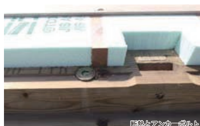
断熱とアンカーボルト ▲土台とアンカーボルトの施工と根太と断熱材の施工例である。右側の断熱材の欠き込みは構造柱の施工位置を示す。土台の欠き込み部分は、防火構造材と断熱材が施工される。防火構造材の隙間を断熱材で防ぐ為に欠き込まれている。この様に欠き込みを行うことにより、断熱と共に気密性能を高める効果がある。
