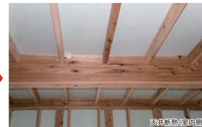
天井断熱(室内側) ▲室内側、天井の断熱施工状況である。梁との隙間部分は、天井側からは、発泡ウレタンが施工されて断熱・気密補強が行われる。この様な緻密で均質な施工が気密性能・断熱性能を高める要となり、高性能を目指す重要な施工となる。
