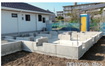
基礎とアンカーボルト ▲完成した耐圧盤布基礎構造である。きれいな基礎が完成している。この様に基礎の型枠を取り外してしまえば、そこにはきれいな基礎だけしか残らない。合理的な施工の原点は、現場仕事の実しさと対応している。基礎の天盤の上に規則正しく立っているボルトは、基礎と土台を繋ぐ。
