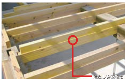
落とし込み根太 ▲土台と平行している構造材が根太である。土台を切り欠いて、根太が施工されている。上の部分は、根太ではなく床の断熱材を受ける受材である。一般的な根太の施工は転ばし根太構造が多い。根太と上部の受材の段差部分にステン断熱材が施工される。
